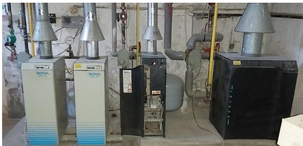
Obrázek 1: Stávající plynová kotelna s kotly Destila 50 kW, 12 kW a 2 x 18 kW
