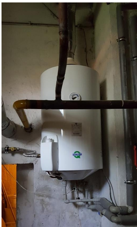
Obrázek 2: Stávající plynový ohřívač vody Quantum Q7-20 KMZ /E
