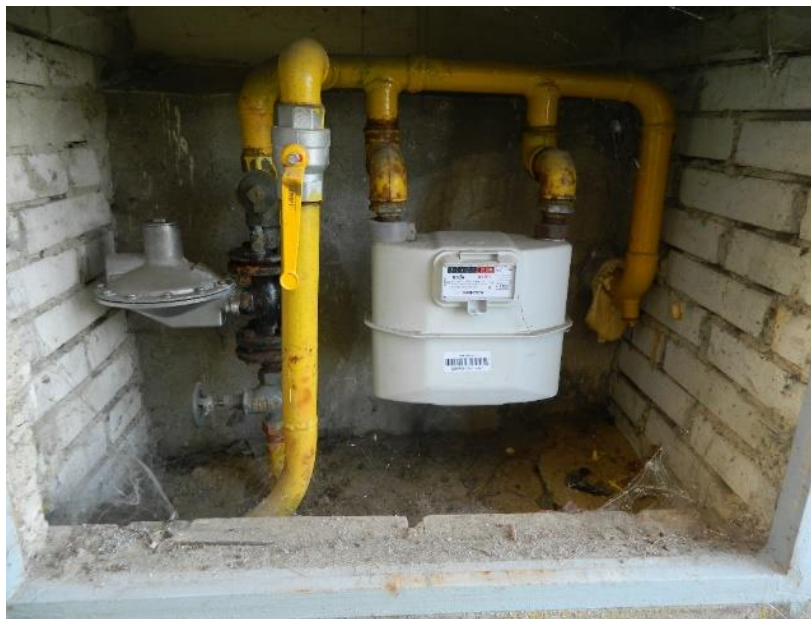
Obrázek 6: Stávající skříň HUP s regulátorem tlaku plynu a plynoměrem na vstupu plynu do „Školky“
