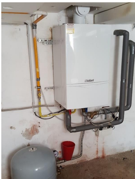
Obrázek 3: Stávající plynový kondenzační kotel Vaillant eco TEC plus VU INT466/4-5
