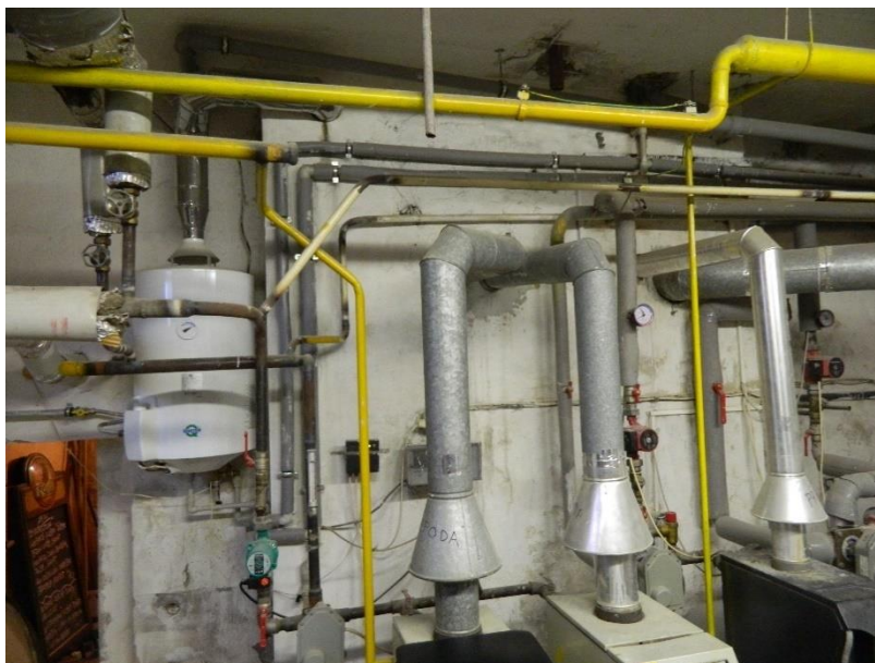
Obrázek 4: Plynoinstalace a odvod spalin v technické místnosti objektu „Multifunkční dům“
