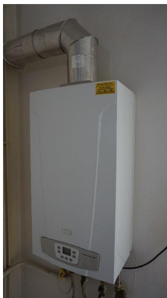
Obrázek 5: Stávající plynový kotel Baxi Mainfour
